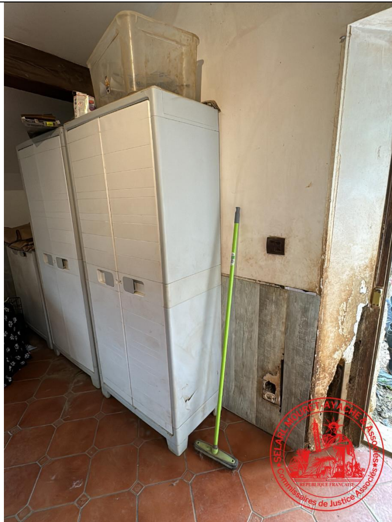
Une porte donne située dans la salle d'eau donne accès à l'espace extérieur.
