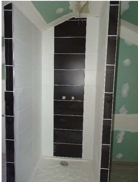
Dans l'angle Sud-Ouest, les murs comportent un doublage en Placoplatre hydrofuge de couleur verte et sont faïencés sur le mur en retour Nord. Les réservations sont en attente dans les murs.
