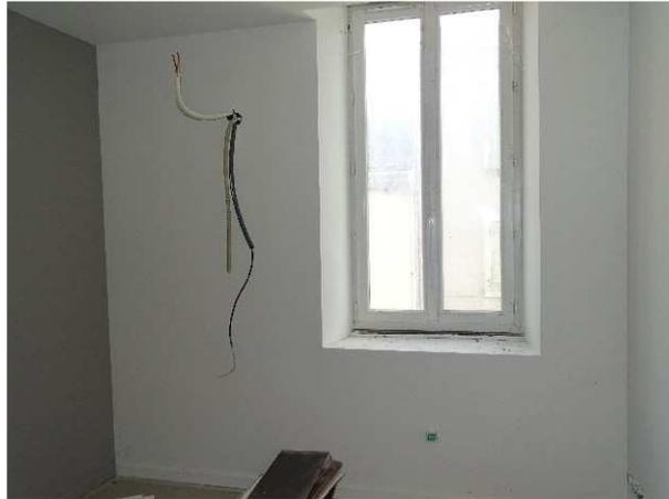
Le plafond est peint, en bon état, et comporte la réservation pour une ampoule d'éclairage. La pièce comporte une fenêtre neuve en PVC, côté Est, comportant un double vitrage.
