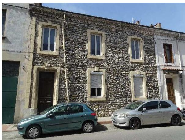
La façade est en pierres, le jointoiment entre les pierres est irrégulier et altéré. L'encadrement de la porte d'entrée comporte des éclats.
