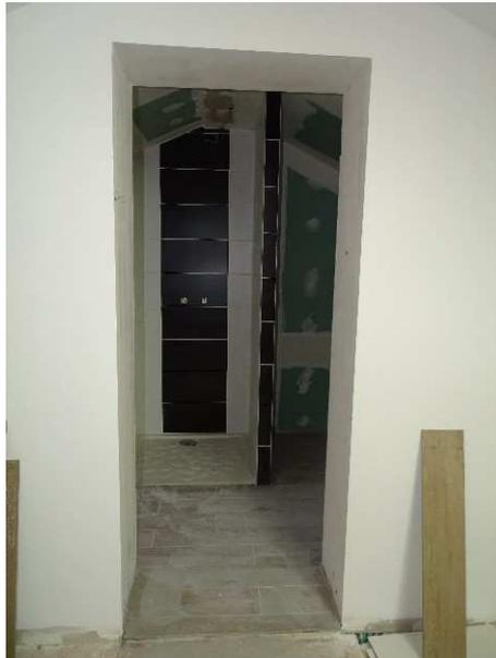
Les murs et le plafond sont en cours de rénovation et comportent un doublage en Placoplatre hydrofuge de couleur verte.
